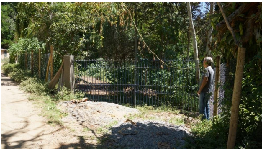
Foto 4 - Instalação de cerca e portão no Horto de espécies medicinais no Vale do Caititu
